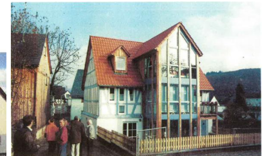
Zum Wohnhaus umgebaute Scheune mit neuem, reduziertem Giebeltrakt
