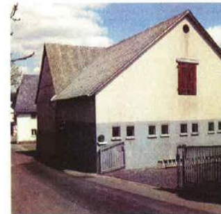
Scheune vor dem Umbau mit großem Stall
