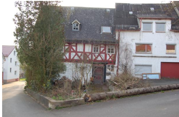
Leerstehende Fachwerkgebäude im Ortskern.
